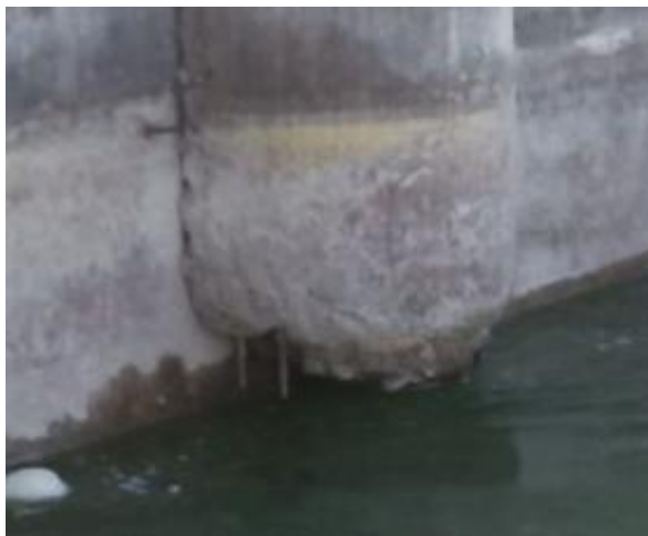
Foto 4.2 - Degrado alla base delle pile
