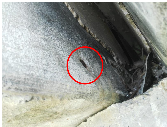
Foto 4.4 – Manufatto limitatore – Appoggio e armature di precompresione
