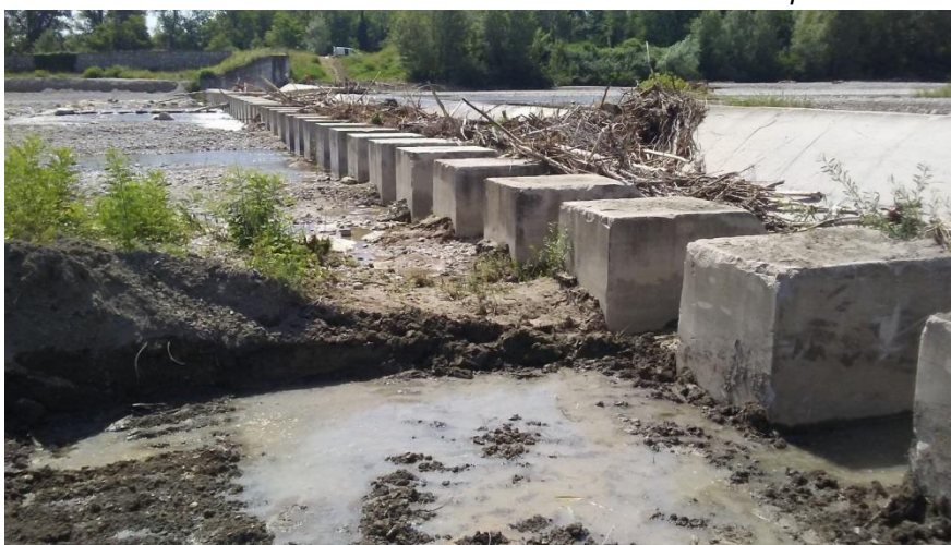
Foto 3.3 - Denti a pettine - Accumulo materiale flottante
