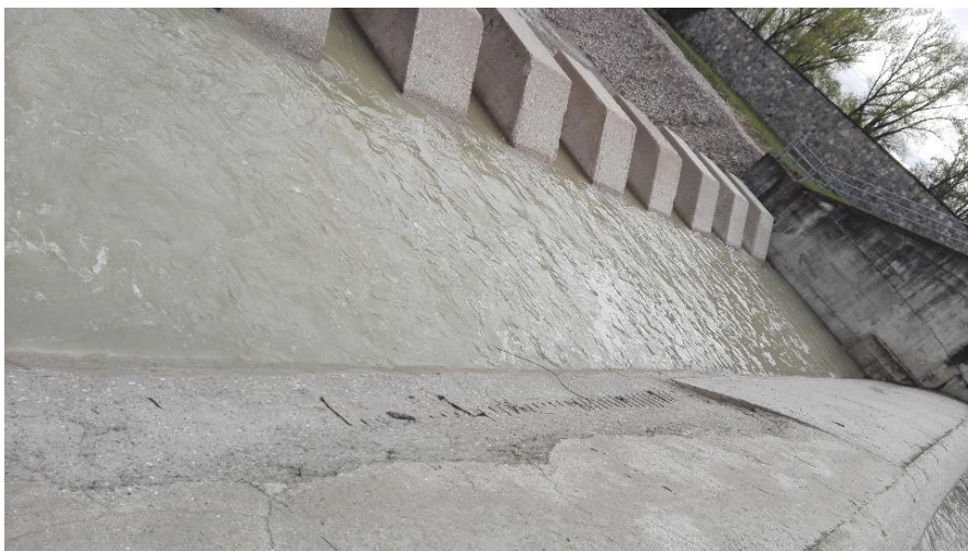
Foto 3.2 - Traversa di monte - Abrasione superficiale
