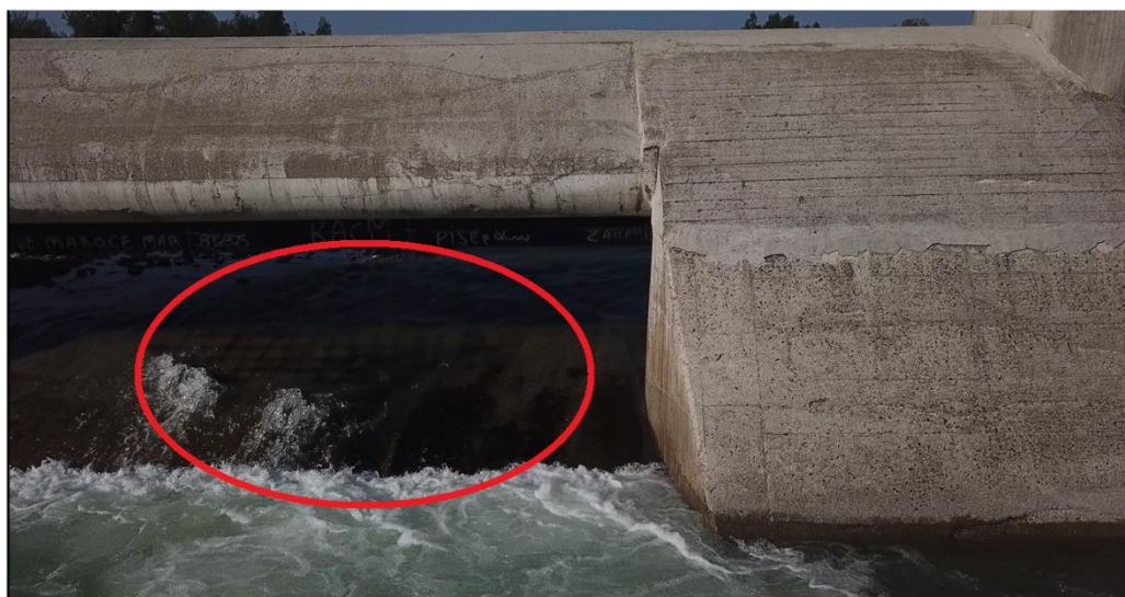
Foto 4.3 – Manufatto limitatore in alveo – Abrasione superficiale
